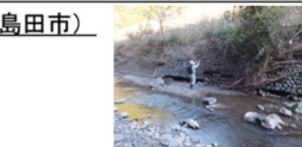
被災構造物の全景をLiDARにてスキャン
